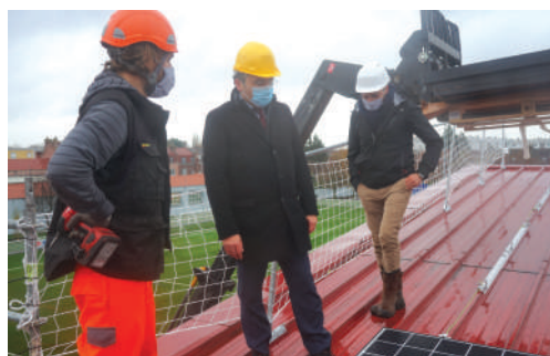
Sébastien Lepretre sur le toit de la tribune du stade Carpentier, pour la pose des premiers panneaux photovoltaïques du plan SOLAMAD - Voir page 18.
