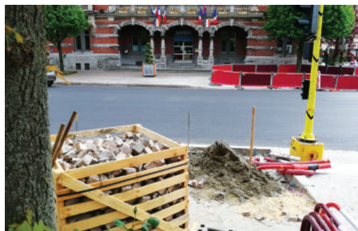
1 à 1, les pavés de la place ont été réinstallés.
